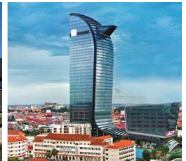
LEED : Silver • Vattanac capital tower . Architecte : TFP Farrells • Phnom Penh (Cambodge)
