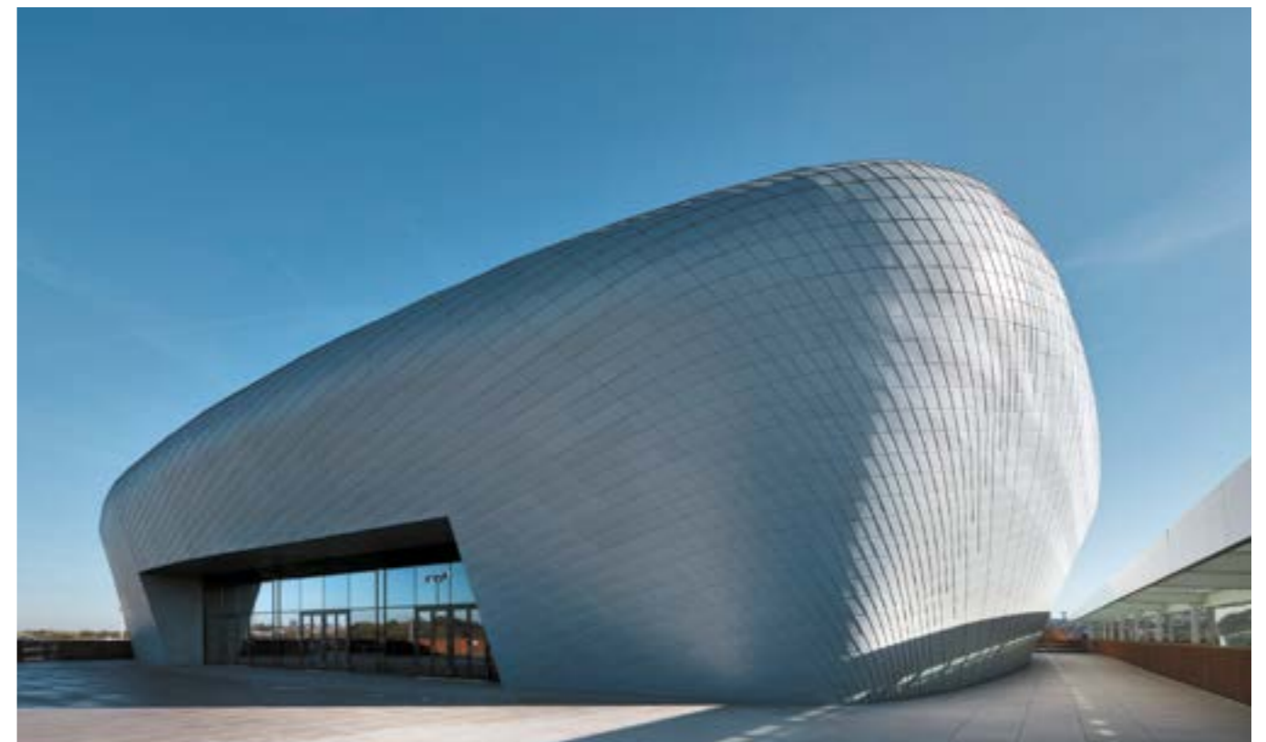
BREEAM • Docks Brussel • Architecte : ART & BUILD • Bruxelles (Belgique)
