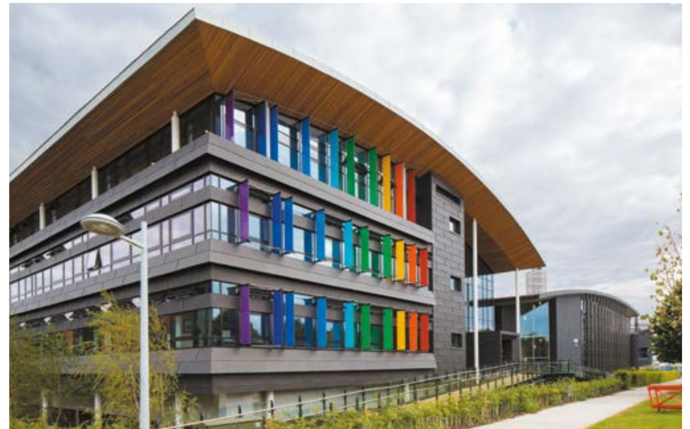
BREEAM • University of Cambridge Maxwell Centre • Architecte : Building Design Partnership (BDP) • Cambridge (Royaume-Uni)
